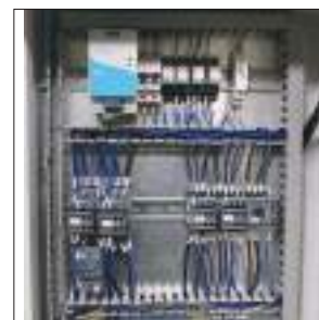
Quadro elettrico Tensione di comando 24 V CC Componentistica elettrica Siemens o Schneider
